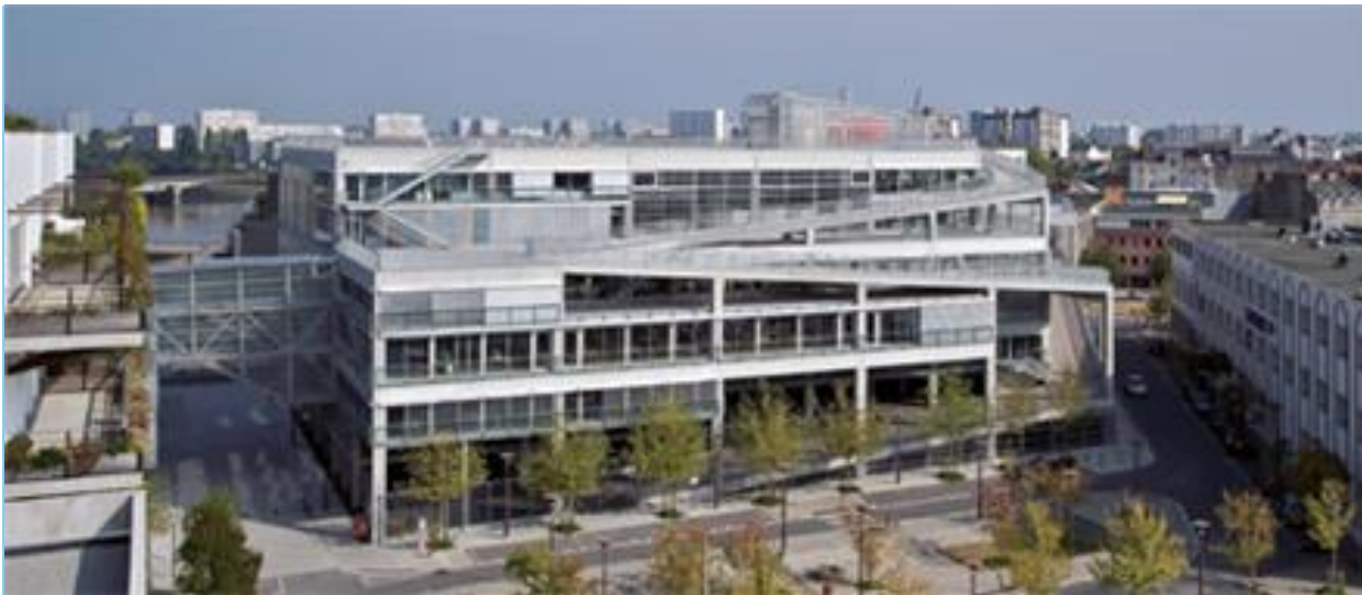
Figure 3 : Vue sur la façade ouest de l'école (photo tirée de la fiche projet Lacaton&Vassal)
